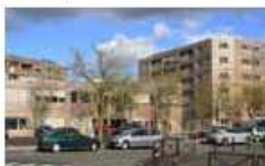
A Bâtiment écologique aux performances de la Maison Passive France
